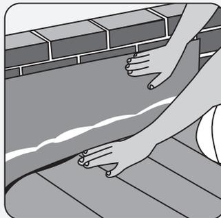
03. Meça o comprimento necessário de Ruflex e corte-o na medida. Cole-o sobre a parede, tomando cuidado para deixá-lo bem alinhado.
