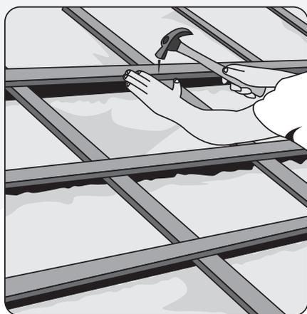
04. Fixe os sarrafos antes de desenrolar o próximo rolo. Assim, você poderá apoiar-se nos sarrafos para fixar os rolos na parte superior do telhado.
