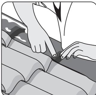
03. Após retirar a película plástica protetora, cole uma extremidade do Ruflex na Tabeira, alinhando-o bem. Cole a outra extremidade nas cristas das telhas e depois molde-a com os dedos, completando a fixação.
